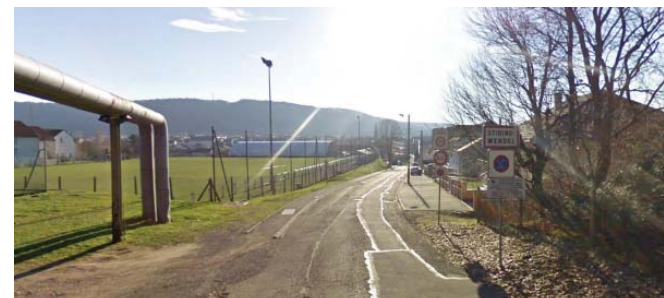
Entrée n°1 depuis la centrale à biomasse de Forbach
