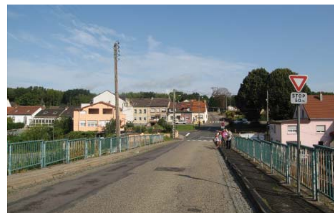
Chemin du Holweg (pont sur la voie ferrée)
