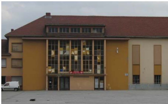
Maison d'oeuvre, façade avant : une composition moderne qui imbrique des éléments symétriques dans un ensemble qui ne l'est pas
