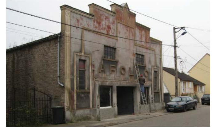
Ancien cinéma Apollo, quartier Vieux Stiring : façade alliant classicisme (symétrie, pilastres) et modernité (fenêtres étirées, fronton à gradins)
