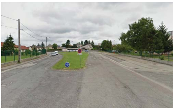
Le parking du collège et ses espaces verts clôturés
