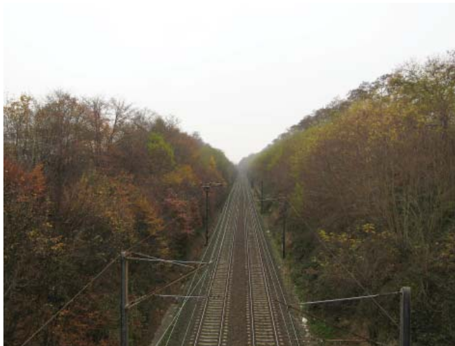
Boisements de part et d'autre de la voie ferrée
