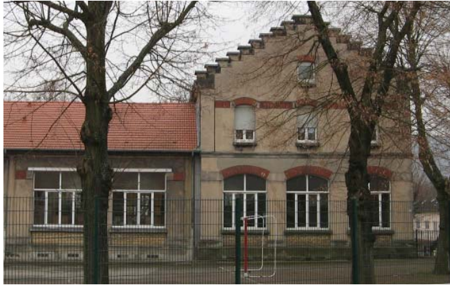
Ecole Vieux Stiring: pignon en gradins inspiré de l'architecture flamande
