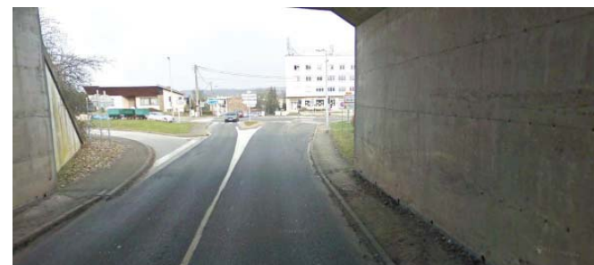
Entrée n°4 depuis Spicheren (passage sous l'A320)
