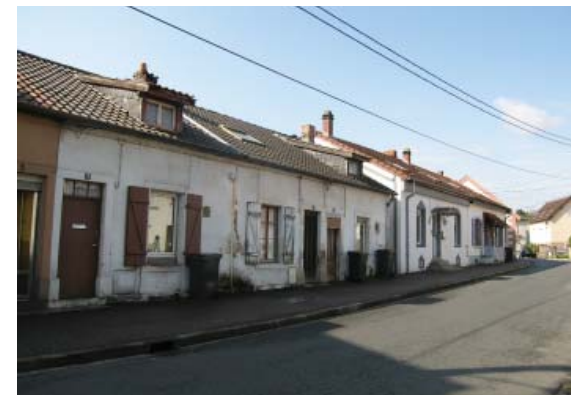
Bâti ancien construit en ordre continu, quartier Verrerie Sophie
