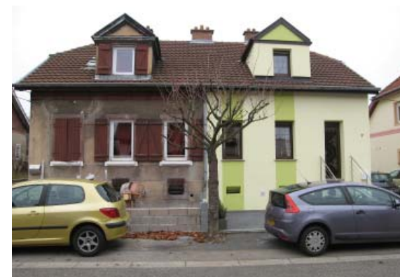
Maisons jumelées de cité, avec pignons latéraux
