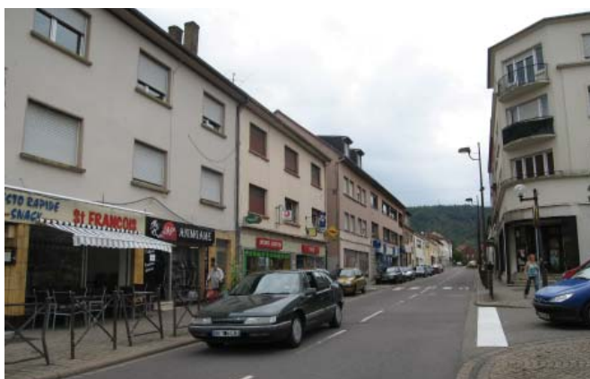
Rue Saint François aménagée en zone 30
