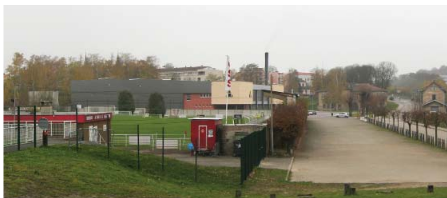
Salle omnisports à l'entrée de la Coulée Verte
