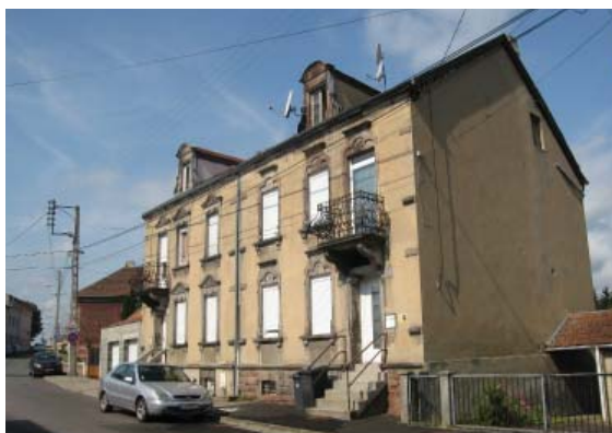
Maisons jumelées de la 1 ère annexion allemande
