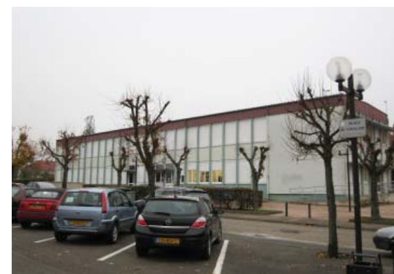
Centre social du Habsterdick
