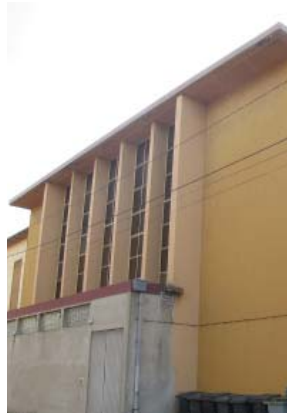
Maison d'oeuvre : lames verticales de la façade arrière
