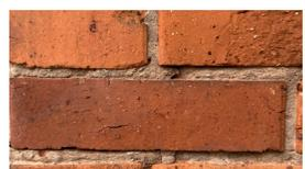
Briques pleines en argile cuite de couleur rouge orangé, moulé à la main avec joint à la chaux hydraulique
