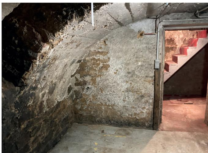
Voûte en pierre d'une maison minière avec perte de l'enduit à la chaux et du mortier structurel - Source : Urbanis & Tholos architecture
