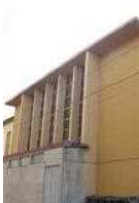
Maison d'oeuvre : lames verticales de la façade arrière
