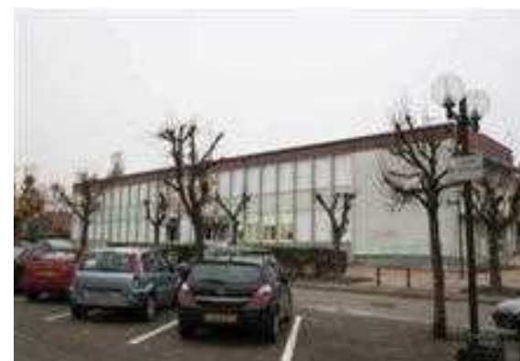
Centre social du Habsterdick
