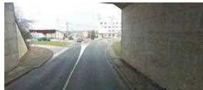
Entrée n°4 depuis Spicheren (passage sous l'A320)
