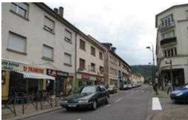
Rue Saint François aménagée en zone 30
