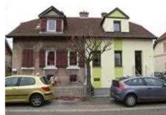
Maisons jumelées de cité, avec pignons latéraux
